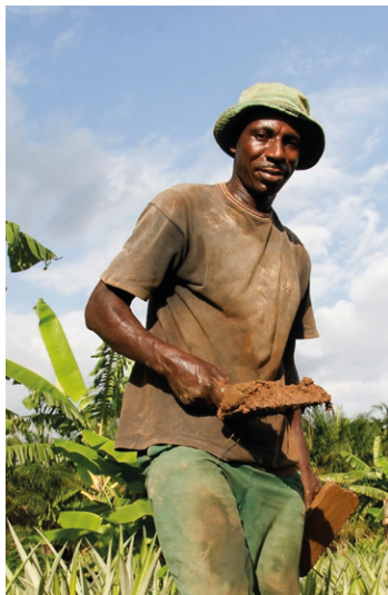
Komi, der Maurer vom Dorf, wird in alle Bauarbeiten involviert
